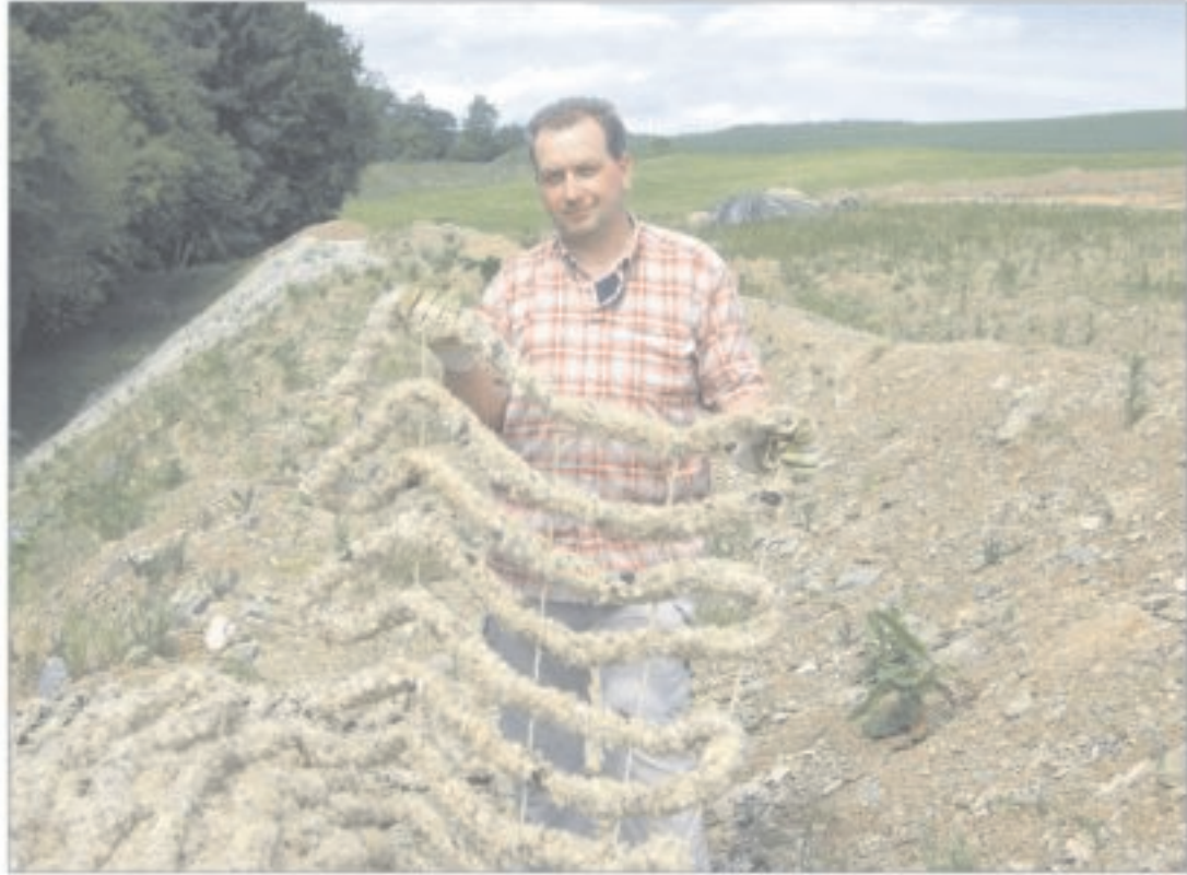
Auferrollt zu Ballen wird die Schafswolle im Lkw angefahren und dann unter anderem von Firmenchef Jan Holland-Moritz selbst über die Steilhänge gelegt.
