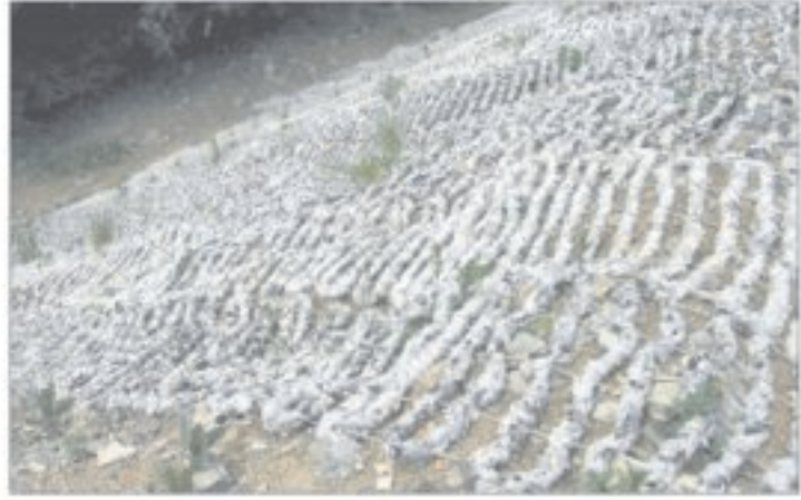
Mit den Schafswollmatten sollen die Begrünung gefördert und Erosionen verhindert werden. ■ Fotos: Jana Sauer
