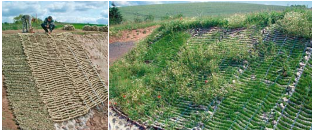
Aufbringen der Vegetationsmatten aus Schafwolle mit eingearbeiteter Samenmischung (links), das Pflanzenwachstum war bereits nach fünf Wochen deutlich sichtbar
