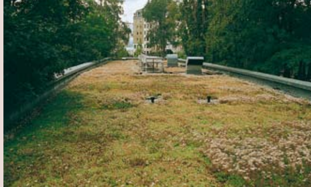
Auf diesem Dach wurde Schafwolle als Trägermaterial verwendet
